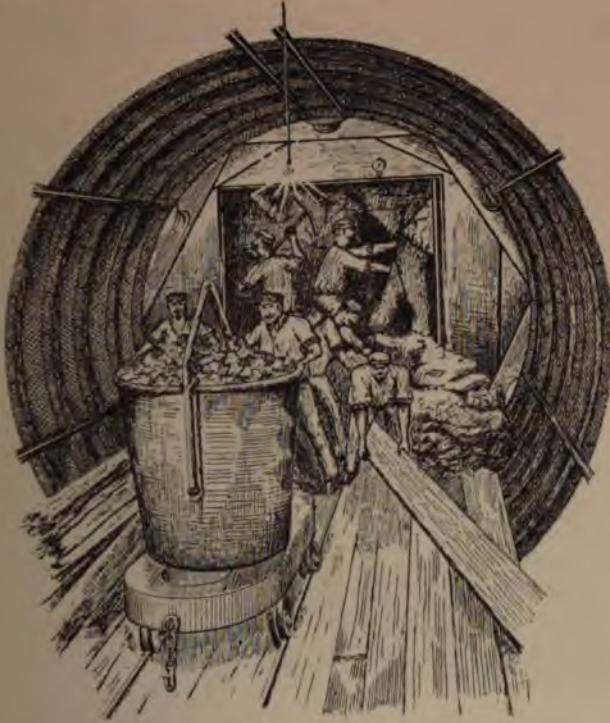
Fig. 275. — Vue du bouclier et de l'attaque.
